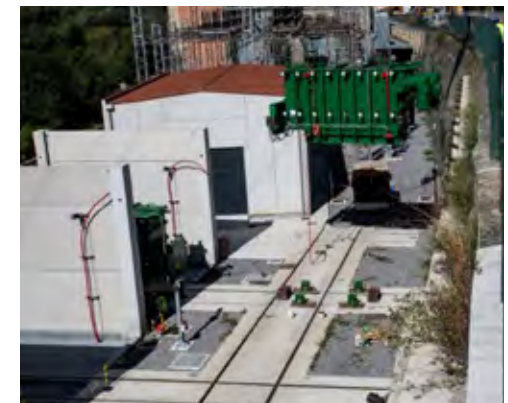
Instalación del nuevo transformador
