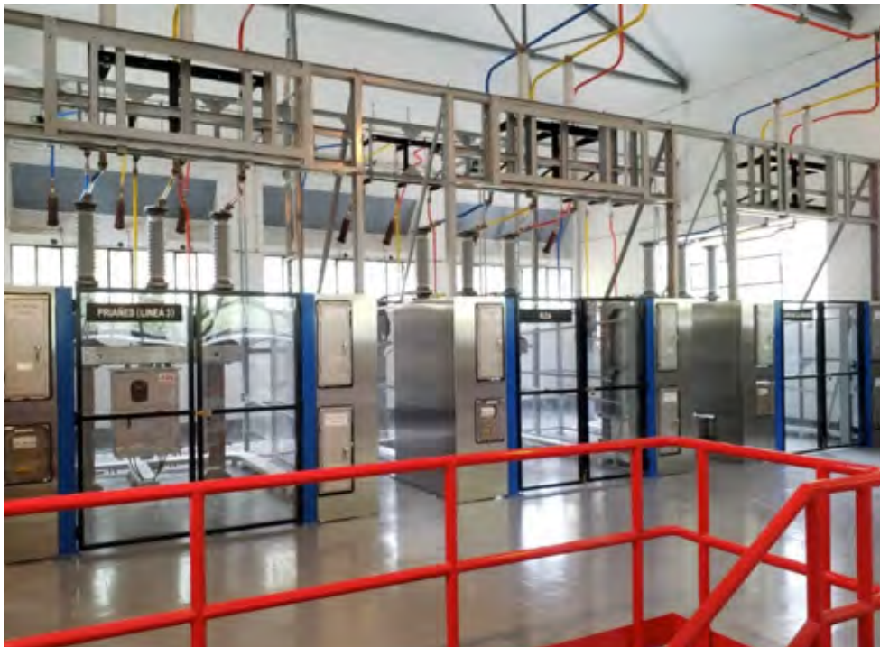
Vista de la obra finalizada
