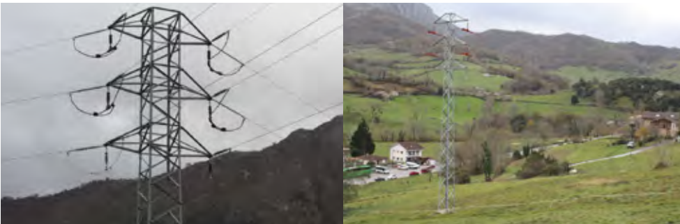
Apoyo con aislamiento renovado
